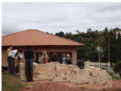
Figura 2: Processo de levantamento das paredes do noborigama (2010) - Fonte: Acervo ICC
