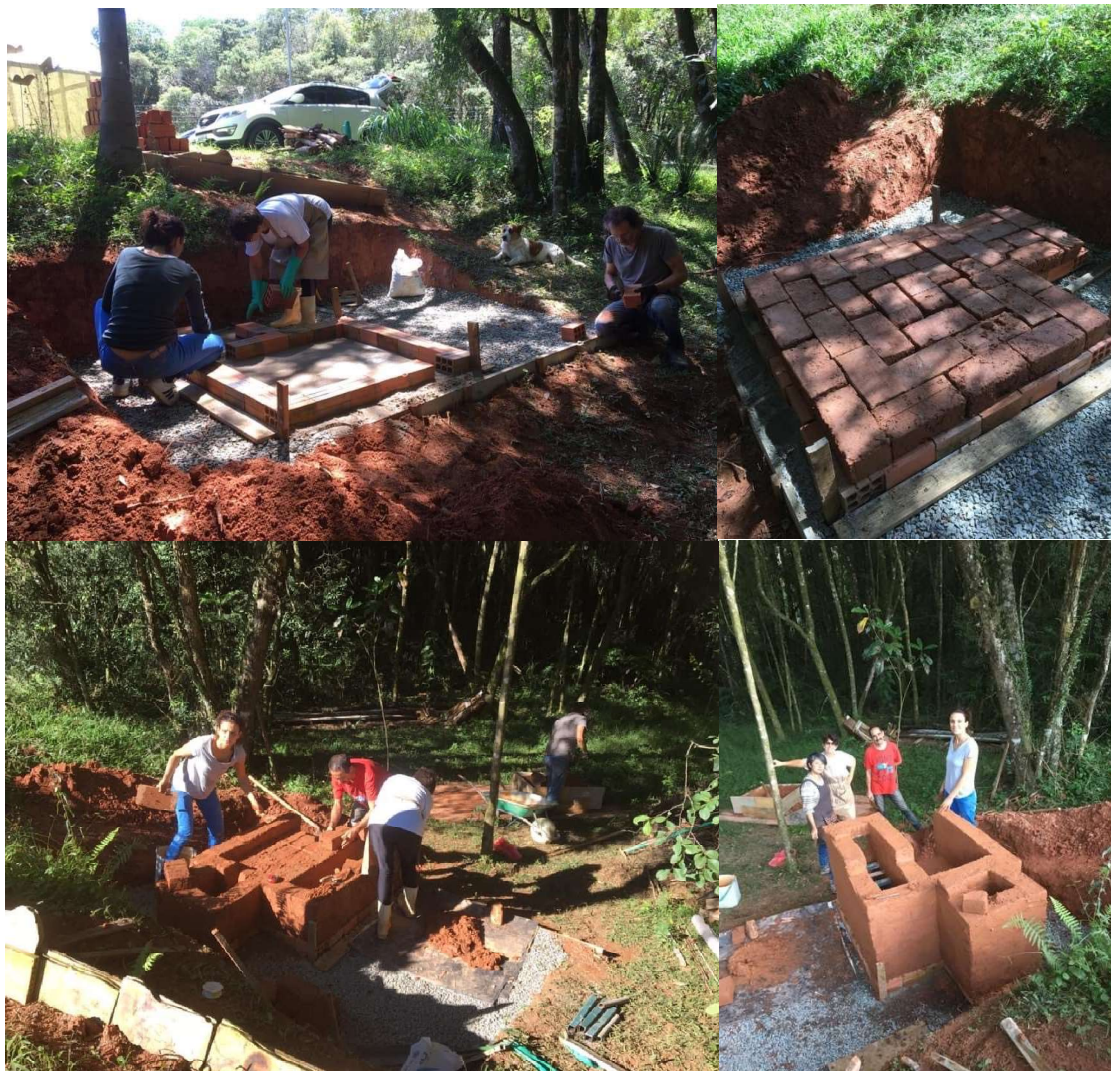
Figura 3 – Construção do Forno
