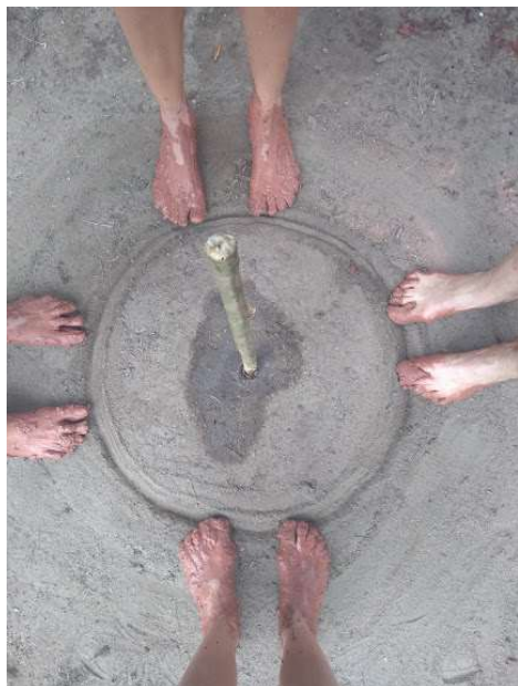
Foto 5 – Início da marcação do forno
