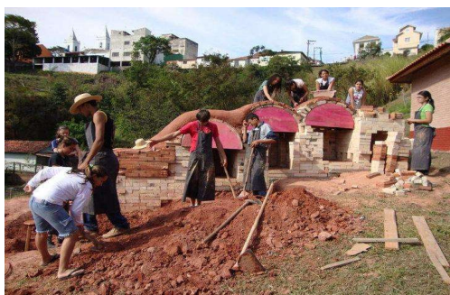
Figura 3: Construção dos arcos (2010) Fonte: Acervo ICC
