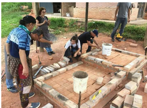
Figura 13: Medição do piso para construção das paredes (2017) - Fonte: Acervo pessoal
