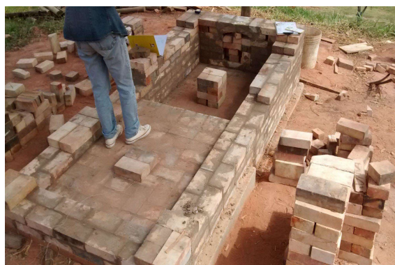
Figura 14: Início da construção das paredes (2017) - Fonte: Acervo pessoal
