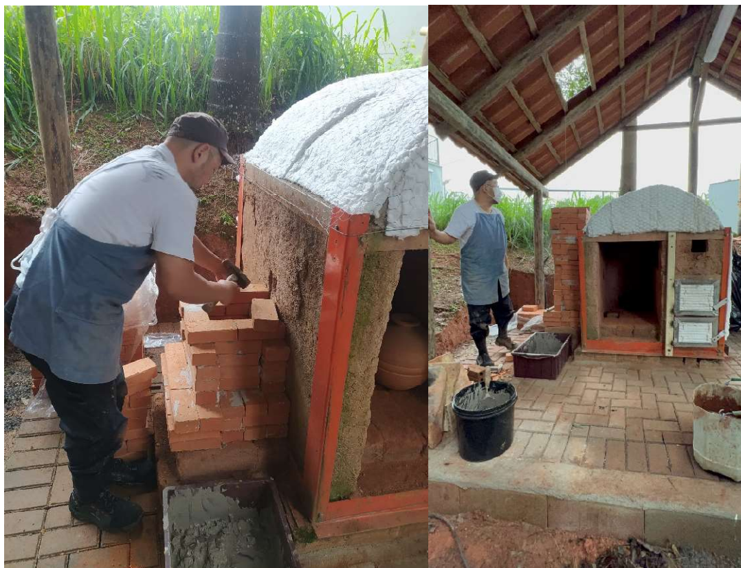
Figura 5 – Construção da nova chaminé
