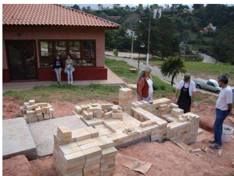
Figura 1: Começo da construção do forno noborigama (2010) - Fonte: Acervo ICC
