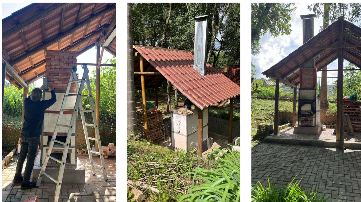
Figura 4 - Construção da Chaminé e Vistas do Forno Pronto
