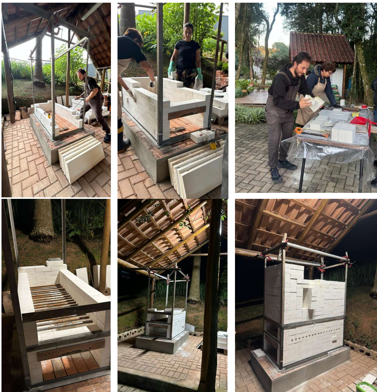
Figura 3 - Etapas de Construção do Forno Fonte: Autora, 2025
